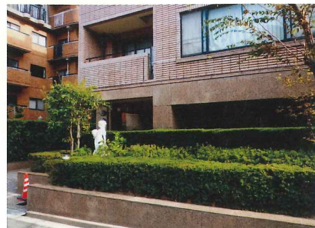
敷地には十分な緑地を設け、近隣にある自然環境の 季節の移ろいに調和しながらプライバシーに考慮。
